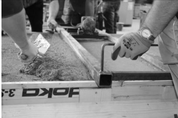
Abbildung 6: Einbau der PVA-faserbewehrte Schicht
