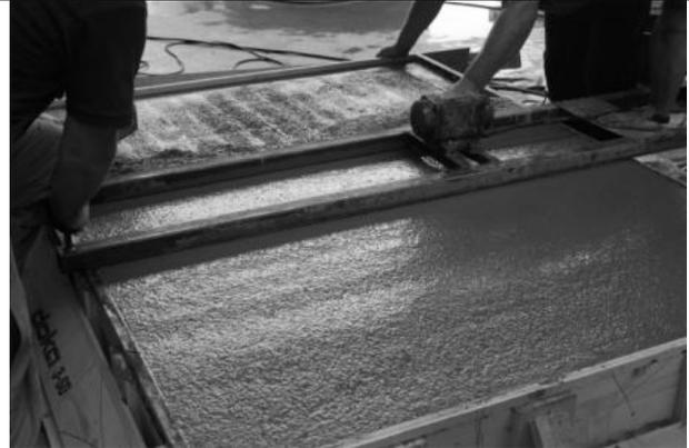
Abbildung 7: Verdichtung der oberen Schicht mit Rüttelbohle
