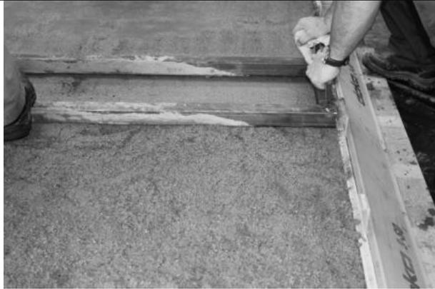
Abbildung 4: Einbau und Verdichtung der unteren Schicht mit Stahlfasern
