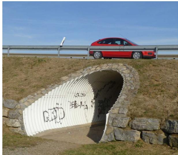
**Bild 1.** Typisches Wellstahlbauwerk als Verkehrswegunterführung
