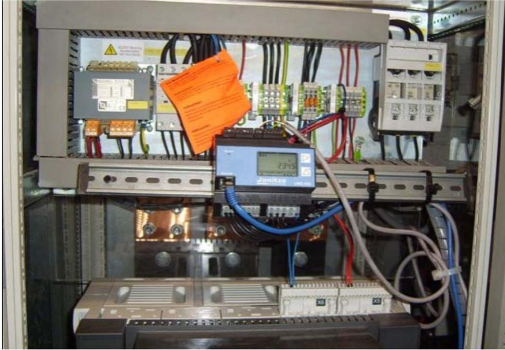
**Bild 14:** Strommesseinrichtung an der 800 t Presse
