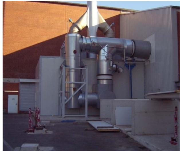
**Bild 24:** Abgasführung mit Hauptabgasleitung von den vier Schmiedeöfen aus der Halle „Hammerwerk“ und Gebläse mit Schallschutz (links) und Abgasführung mit Dämmung der heißen Rohrleitung inkl. Schallschutz (rechts)
