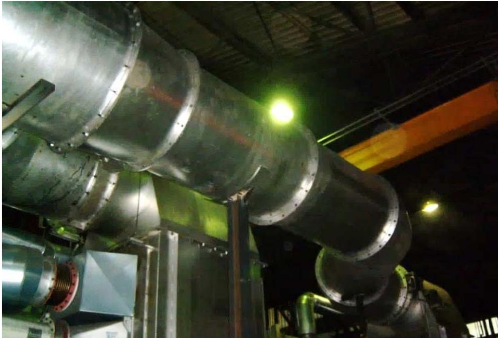
**Bild 25:** Abgasführung (Dämmung der heißen Rohrleitung DN 630 – 1400 mm inkl. Schallschutz)
