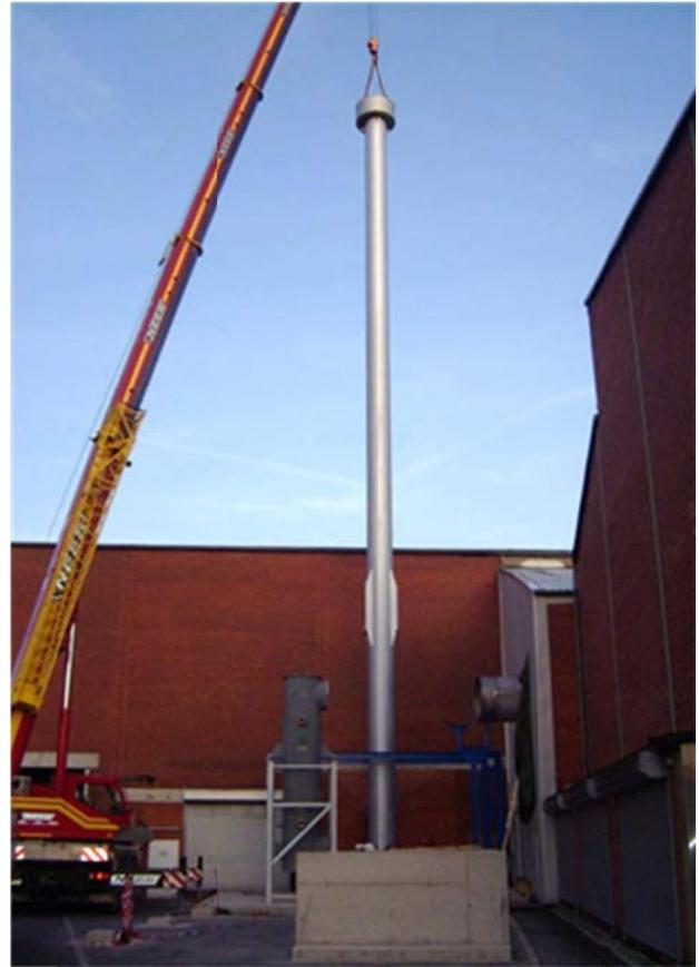
**Bild 23:** Installation des Abgaskamins bei Grimm vor der Halle „Hammerwerk“
