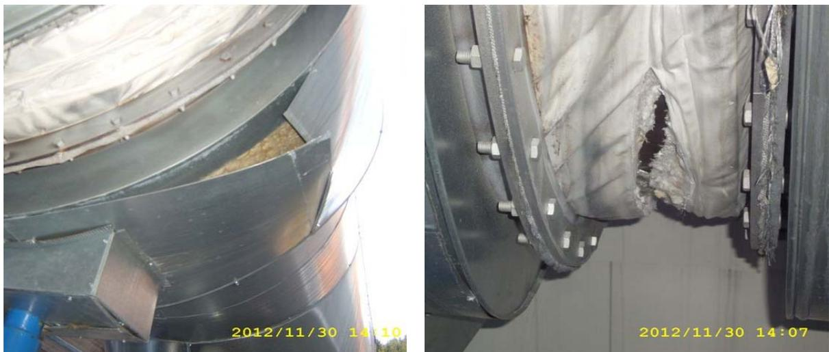
**Bild 33:** Beschädigung der Abgassammelleitung (links) und des Kompensators in der Abgassammelleitung (rechts)
