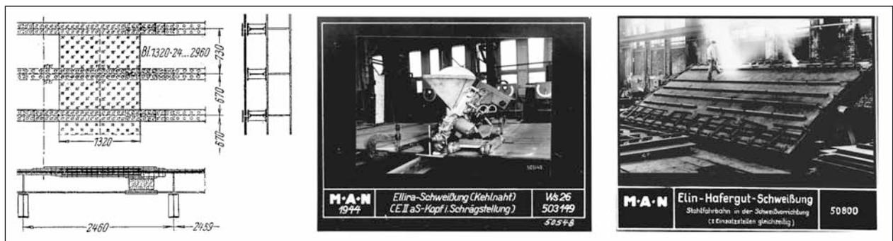
**Bild 2:** Verbindungstechniken: Straßenbrücke über den Rhein von Köln nach Deutz – genietete Orthotrope Platte (LEONHARDT [58], Seite 197), Unterpulver-Schweißmaschine (Bilderarchiv [86]), Stahlfahrbahn in der Schweißvorrichtung (Bilderarchiv [86])
