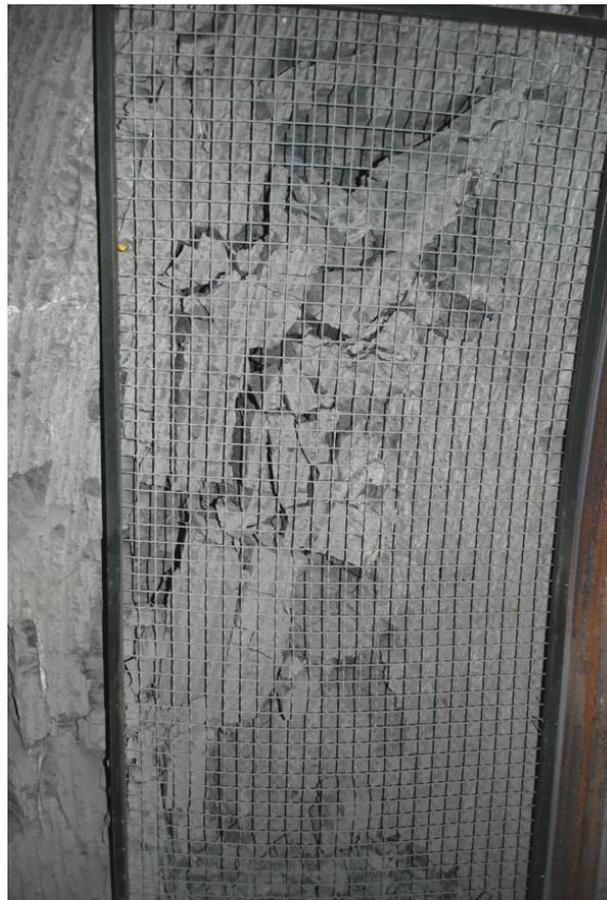
*Bild 3.65: Detailaufnahme des gesicherten Konturbereiches mit Gesteinsauflockerung im Bereich der sekundären Störungszone im Stoß des westlichen Teils der Gallery 96*
