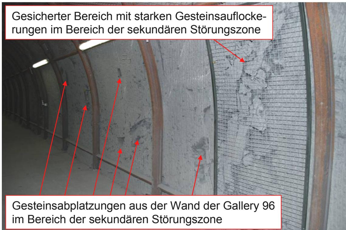
*Bild 3.64: Gesteinsabplatzungen und gesicherter Bereich mit Gesteinsauflockerung im Bereich der sekundären Störungszone im Stoßbereich des westlichen Teils der Gallery 96*
