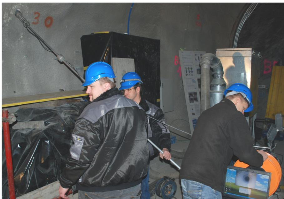
*Bild 3.3: Ingenieur und zwei Techniker des LfD&G beim Einbringen der Axial-Bohrlochkamera in das Observationsbohrloch DMB-B3*
