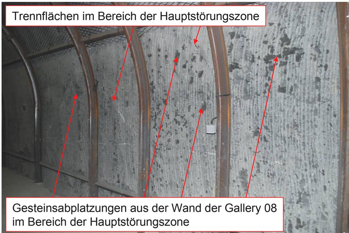
*Bild 3.67: Gesteinsabplatzungen und Trennflächen im Bereich der Hauptstörungszone im Stoß der Gallery 08 (Verlängerung des westlichen Teils der Gallery 96)*
