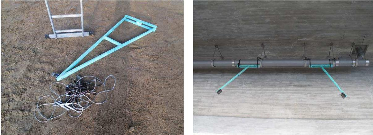
**Abbildung 19:** Kamerahalterungen am Standort Demonstrator-2, Brücke Jarmen
