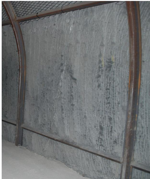
*Bild 9.6: Verlängerung des Westteils des Querstollens 1996: Kontur im Stoßbereich in Höhe der main fault (oben) mit Detailaufnahme (unten links) sowie Kontur im tektonisch ungestörten Bereich westlich der main fault (unten rechts), alle Aufnahmen von Oktober 2010*
