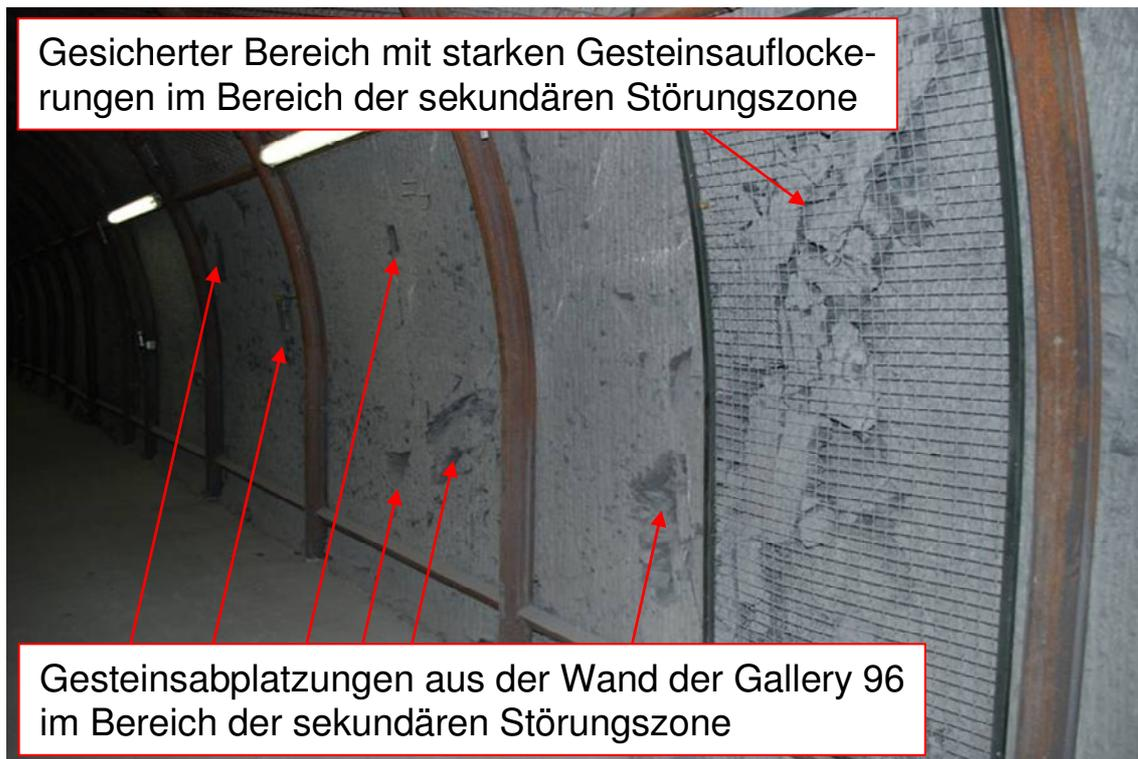
*Bild 4.36: Gesteinsabplatzungen und gesicherter Bereich mit Gesteinsauflockerung im Bereich der sekundären Störungszone im Stoßbereich des westlichen Teils der Gallery 96*
