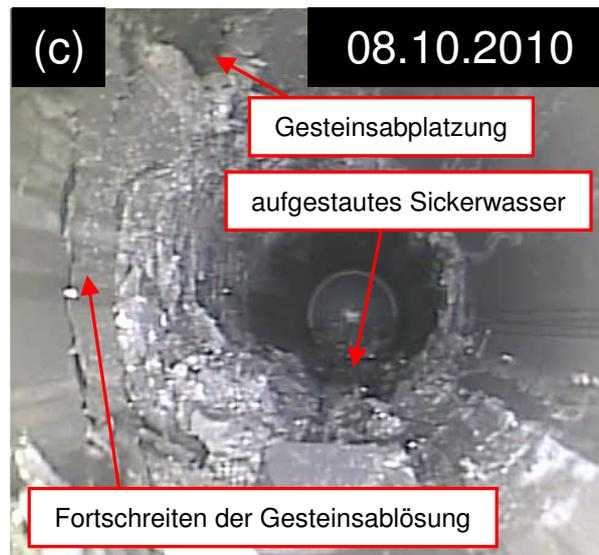
*Bild 4.84: Vergrößerte Darstellung von Bild 4.82(c) mit einer grafischen Kennzeichnung von einer Gesteinsabplatzung im Firstbereich, einer fortschreitenden Herauslösung von Gestein aus der Bohrlochwand heraus sowie von aufgestautem Sickerwasser im hinteren Teufenbereich des Bohrlochs GSM 90*
