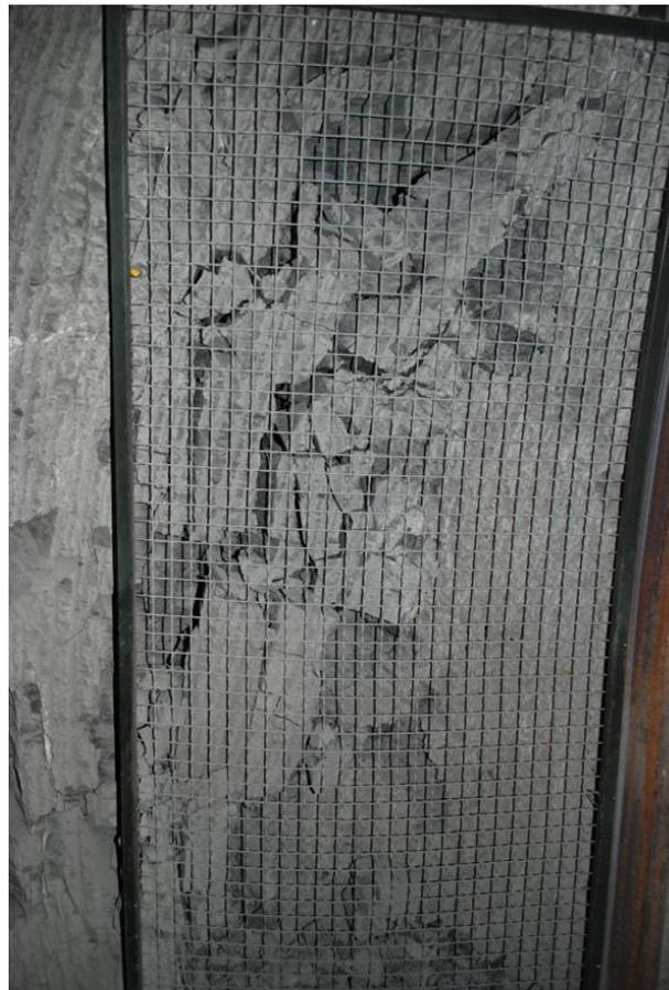
*Bild 4.37: Detailaufnahme des gesicherten Konturbereiches mit Gesteinsauflockerung im Bereich der sekundären Störungszone im Stoß des westlichen Teils der Gallery 96*
