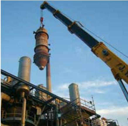
Demontage 40t Wärmetauscher
