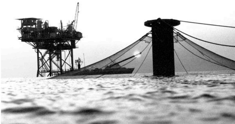
Abb. 24 Klasse III Käfig der Firma OST in Kombination mit einer Offshore-Ölplattform im Golf von Mexiko. SEA GRANT (2000)
