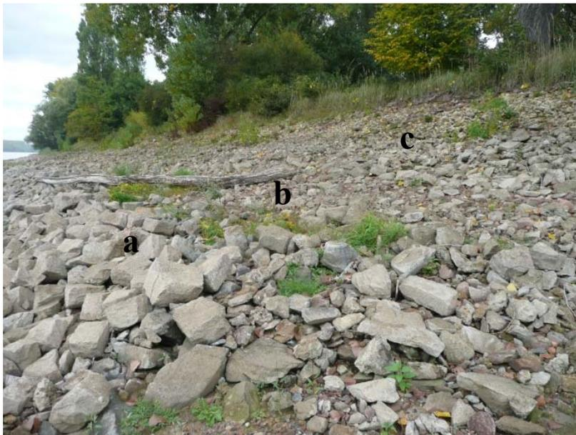
Abbildung 2-5: Manahme 2 - Ufer nach Entfernen der Wasserbausteine unter Belassen der Fusicherung in Zone a und der historischen Ufersicherung am 06.10. 2015, Rhein-km 475,05.
