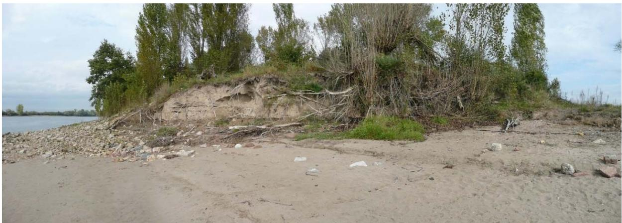
Abbildung 4-3: Mehr als 2 m hoher Uferabbruch zwei Jahre nach dem Rückbau der oberstromigen Rampe (Maßnahme 1). Die sandige Böschung im Vordergrund markiert die ehemalige Rampenfläche. Rhein-km 474,72, 08. 10. 2014
