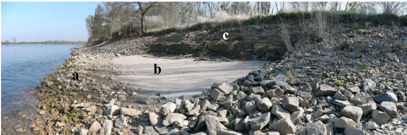
Abbildung 2-7: Maßnahme 4 - Uferböschung nach Entfernung der Reste der historischen Ufersicherung und nachfolgender Erosion am 27. 03. 2014, Rhein-km 475,15. Das neue Uferprofil stellte sich bereits ein halbes Jahr nach dem Abräumen der Stickung ein. Die verbliebene Fußsicherung lag zum Aufnahmeterrain zum Teil unter Wasser. Auf dem angrenzenden Ufer wurden Wasserbausteine oberhalb MW abgeräumt (Maßnahme 2), danach fanden keine weiteren Maßnahmen statt.
