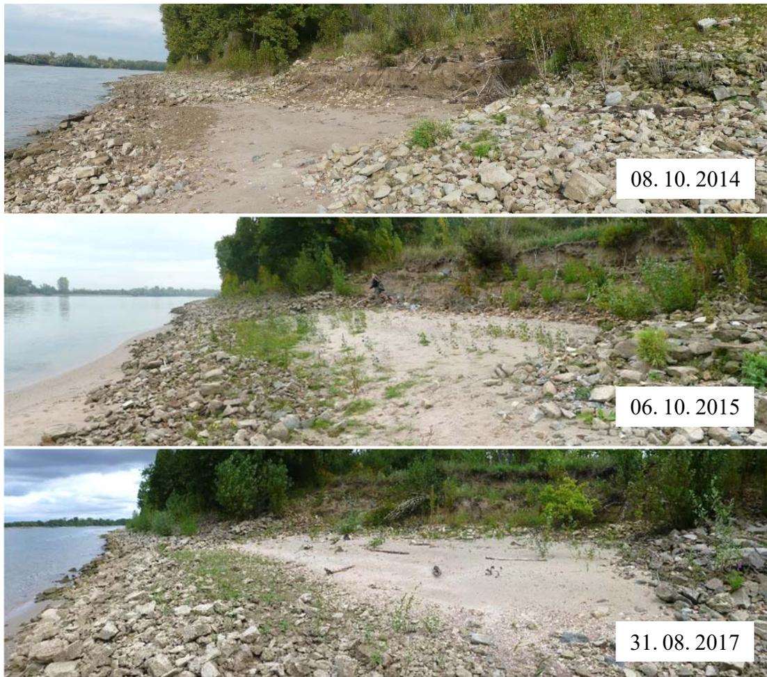
Abbildung 4-7: Maßnahme 4 (Wasserbausteine und historische Ufersicherung entfernt, Fußsicherung belassen) bei Rhein-km 474,86 von 2014 bis 2017.
