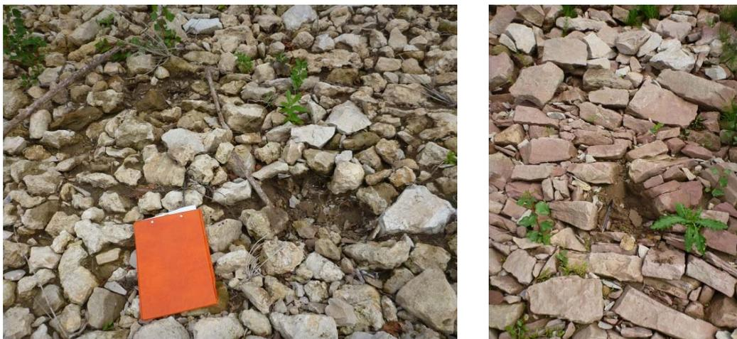
Abbildung 2-6: Manahme 2 in der oberen Bschungszone. Stckung aus einlagiger Steinpackung, historische Ufersicherung, 27.08.2013. Links Dolomit, rechts Buntsandstein.
