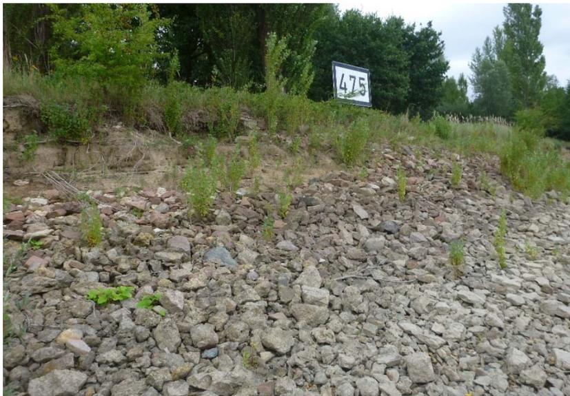
Abbildung 4-2: Uferabbruch mit lehmigem Substrat in der oberen Böschungszone nach dem Abräumen der Wasserbausteine unter Verbleib der historischen Ufersicherung (Maßnahme 3), 31. 08. 2017
